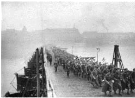
Un transport des troupes à travers le pont du Rhin à Coblence (Bundesarchiv, Bild 146-1976-076-25A)
